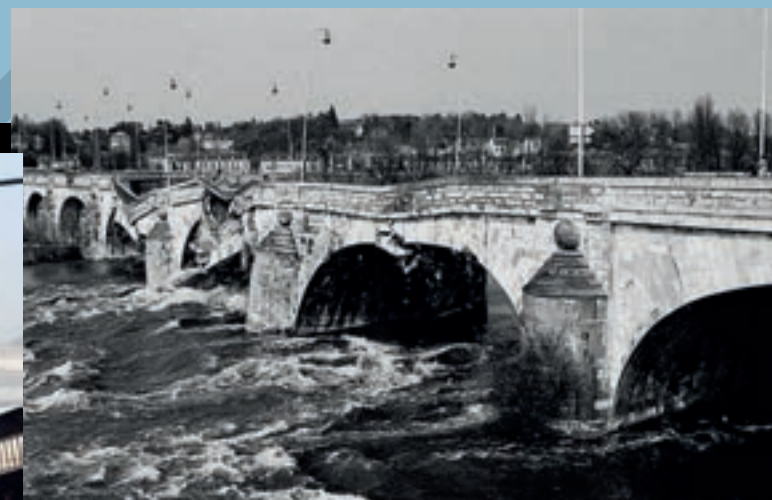
Effondrement du Pont Wilson à Tours en avril 1978.
