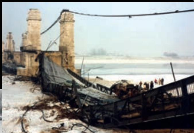
Test de charge avec des chars sur le pont du Cadre Noir à Saumur en 1981. Il a depuis été doublé.
