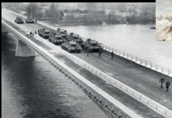
Test de charge avec des chars sur le pont du Cadre Noir à Saumur en 1981. Il a depuis été doublé.
