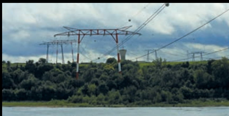
Lignes à haute-tension traversant la Loire à Montsoreau. © MISSION VAL DE LOIRE.
