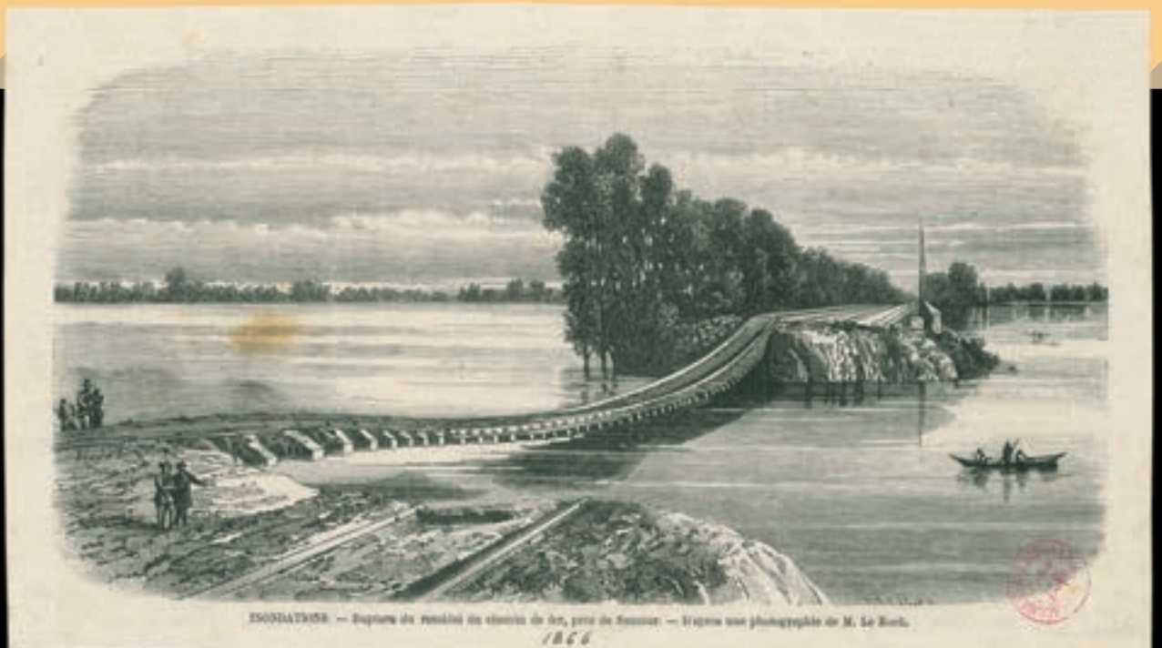
Inondation de 1866 : rupture du remblai de chemin de fer près de Saumur. © ARCHIVES DÉPARTEMENTALES DE MAINE-ET-LOIRE.
