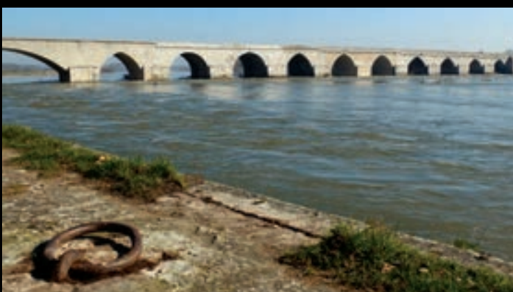
Le pont de Beaugency, dans le Loiret.
