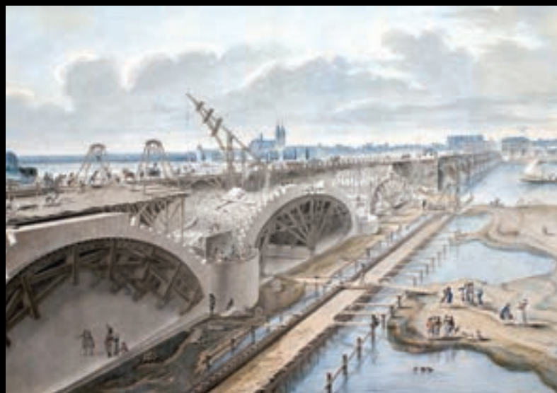
Travaux du Pont de Tours.
