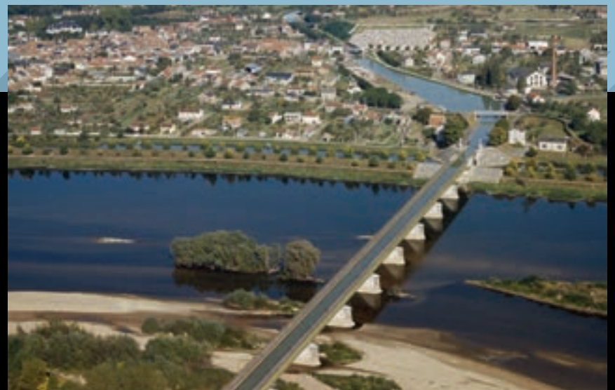
Pont canal de Briare, vue aérienne.
