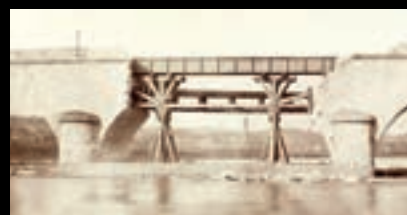
Pont de Montlouis sur la Loire, vue de l'arche brisée rive droite 1871.
